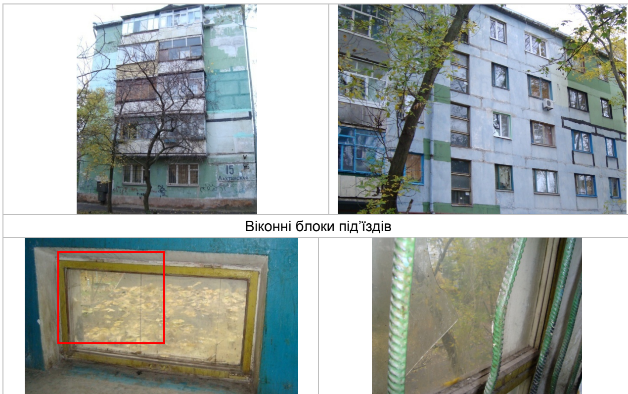
Рисунок 4.2.1. Зовнішній вигляд віконних та балконних блоків будівлі
