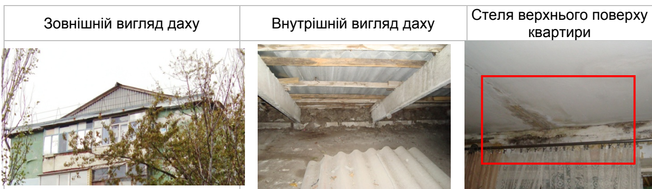
Рисунок 4.4.1. Вигляд перекриття даху
