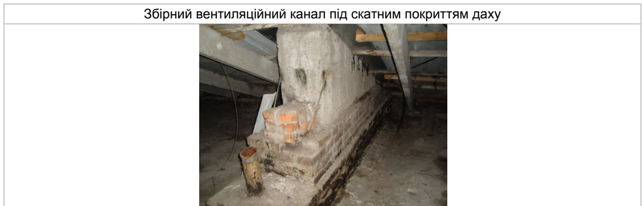
Рисунок 5.4.1. Вентиляційна система
