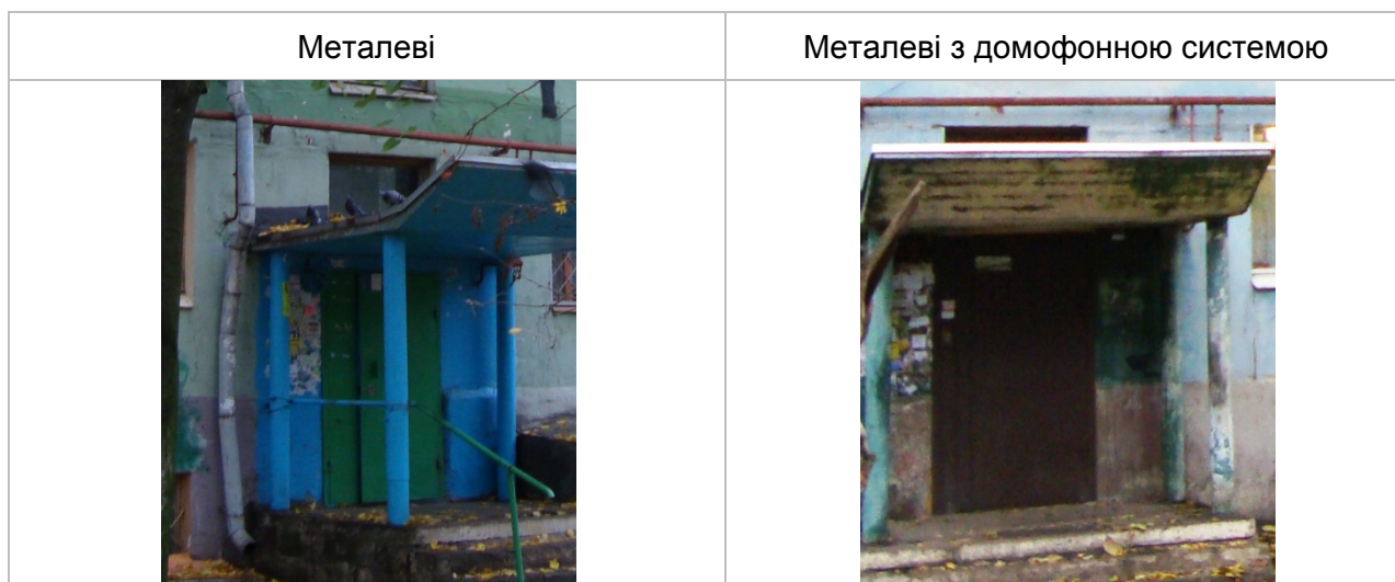
Рисунок 4.3.1. Зовнішній вигляд під'їзних дверей будівлі
